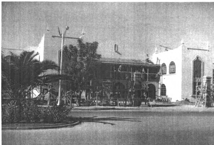
El edificio original en plena remodelación.
